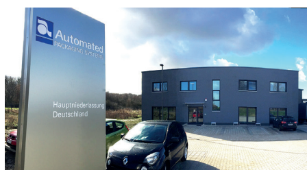
Der neue Sitz der APS-Hauptniederlassung in Wolfenbüttel
