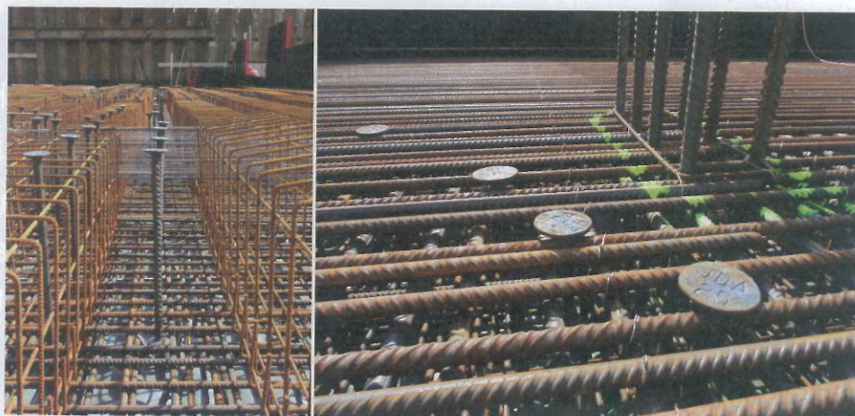
Besonders tragfähige Fundamente entstehen mit Durchstanzbewehrung JDA.
